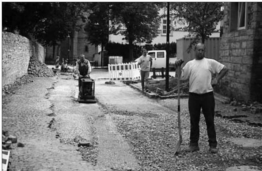
Mitarbeiter der Tudorfer Firma Montag bei den Pflasterarbeiten an der Straße Burgwall
