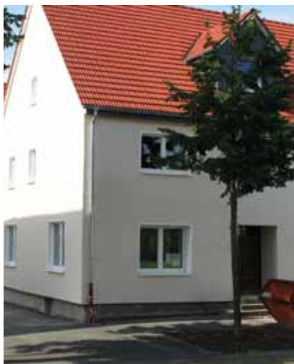
Die bereits fertiggestellte Außenfassade mit Fenstern und Dacheindeckung
