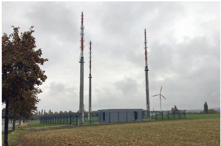
Noch im Jahr 2016 sollen die drei neuen 34 Meter hohen Masten am Alten Hellweg oberhalb von Brenken in Betrieb genommen werden. Bei dem Bauprojekt handelt es sich um eine Erneuerung der Infrastruktur, durch die weiterhin ein sicherer Flugverkehr gewährleistet werden soll.
