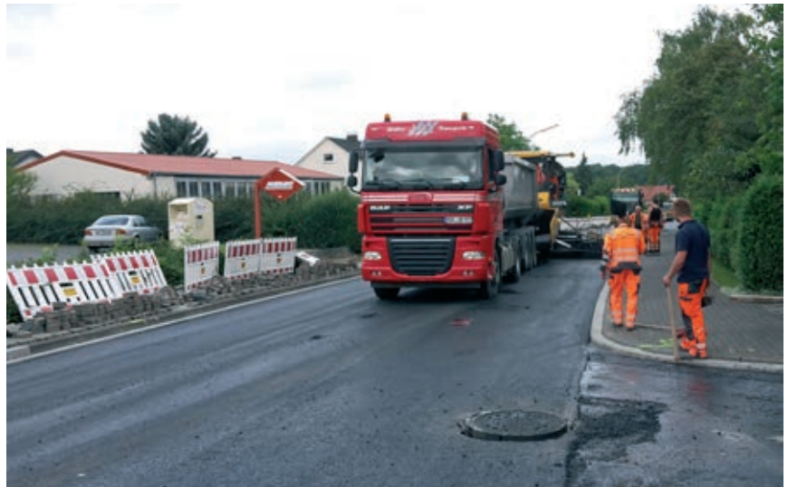
Sanierung der Ortsdurchfahrt (Salzkottener Straße)
