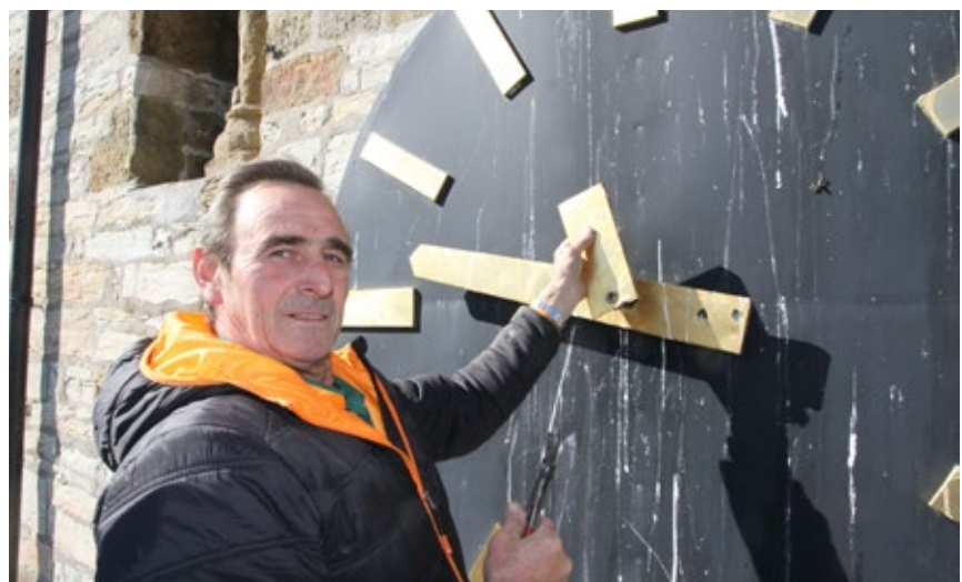
Eckhard Wende hat sich per Kran zur Ostseite des Kirchturms hieven lassen, um den Rest des Minutenzeigers abzumontieren. Foto: Johannes Büttner
