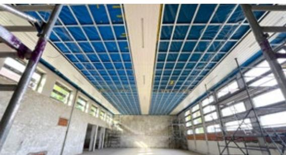
Die Deckenstrahlheizung in der Turnhalle der Josefsschule wurde bereits angebracht. Als nächstes steht die Installation der neuen Lüftungsanlage an (Foto: Stadt Büren)
